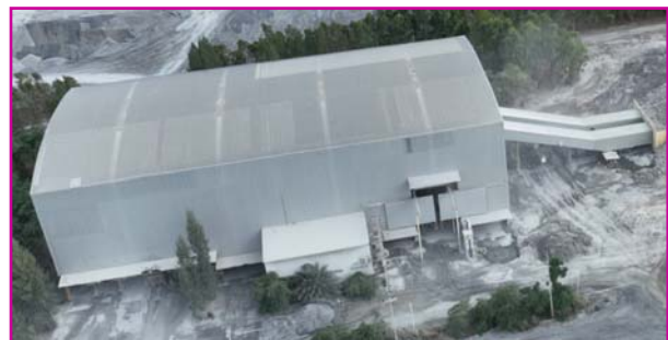
ตัวอย่างภาพอาคารปิดคลุมเครื่องจักรบดละเอียดเพื่อป้องกันฝุ่น
