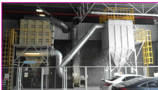
ตัวอย่าง ระบบ Impulse Bag filter กำจัดฝุ่นในระบบการผลิต
